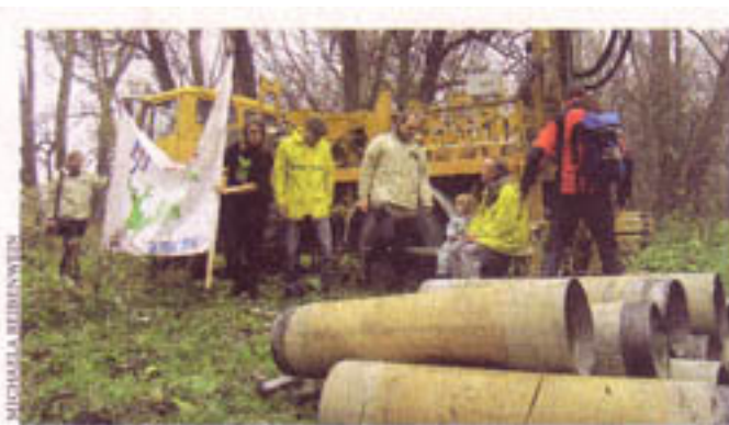
Die Posten bei den Bohrgeräten sollen bald abgezogen werden
