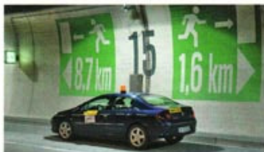
Langstreckenläufer. Langer Weg ins Freie, aber alle 1,5 km „Rettdungsdom“ im Arbergtunnel.
