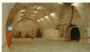
Sicherer Rückzug. Flucht-Dom im Arberg zwischen Straßen- und Bahntunnel.
