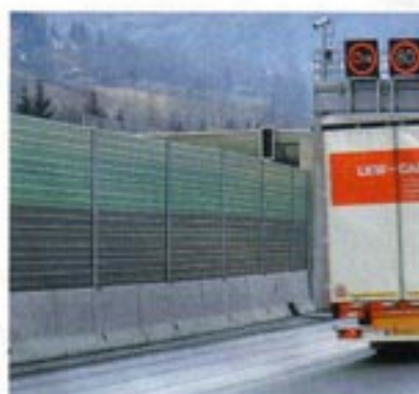
Vorbildlich. Lärmschutztunnel Trebesing in Kärnten auf der A10.
