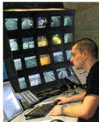
Auf 40 Monitoren beobachten jeweils zwei Operatoren die Hot-Spots im Tunnelsystem von NÖ und Wien. Foto: Baryli
