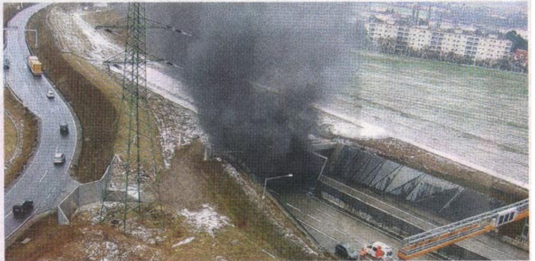
Worst Case – Feuer im Tunnel. Am Donnerstag der Vorwoche funktionierte das Alarmsystem. Foto: ÖAMTC
