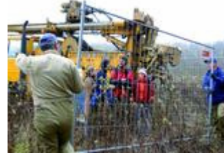
Aktivisten ließen sich in den Bauzaun einsperren und vereitelten Bohrungen. Foto: apa
