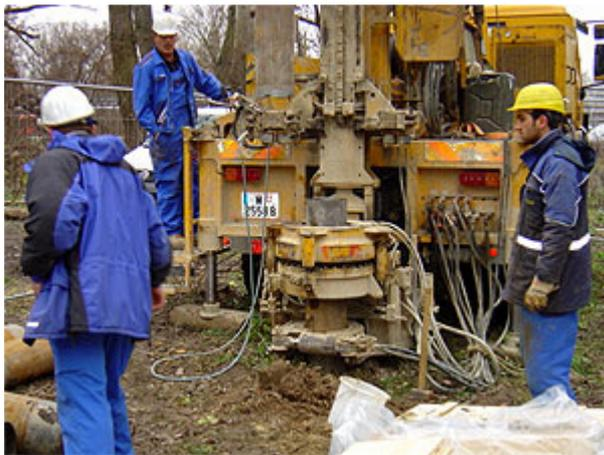
Mit den Bohrungen will die ASFINAG den Untergrund in der Lobau für den Bau des S1-Tunnels erkunden.
