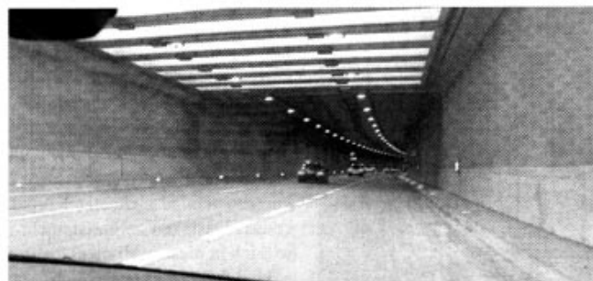
So soll es sein. Helle Tunneleinfahrt, Pannestreifen, Gehsteig als Fluchtweg.
