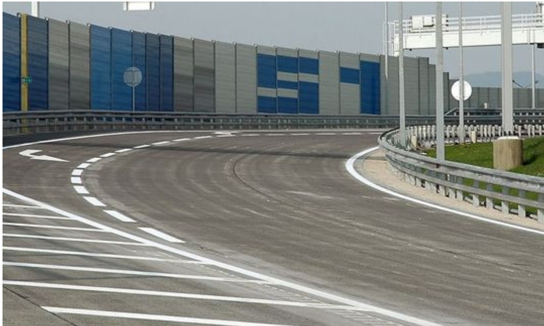
Archivbild: Ein Abschnitt der S1 zwischen Vösendorf und Schwechat. / Bild: APA
